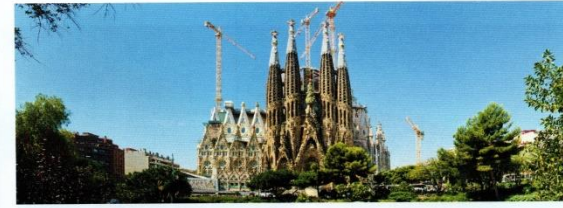
2.88 Zabytek z XX w. (budowa nieukończona) – kościół Sagrada Familia w Barcelonie (Hiszpania)
